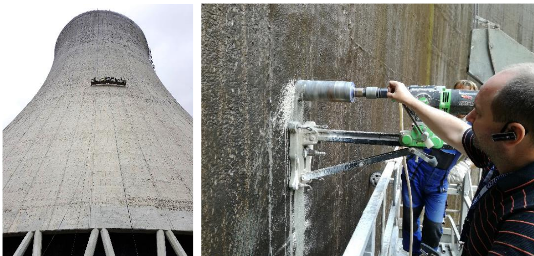
Stavebně-technický průzkum, kontrola železobetonových konstrukcí.
